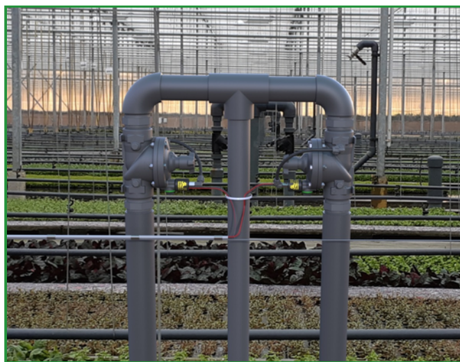
[1] El modelo IR-21T-N5-2W-M de BERMAD se abre y cierra herméticamente en respuesta a una señal eléctrica, lo que hace que el solenoide abra o cierre el circuito hidráulico interno de la válvula
